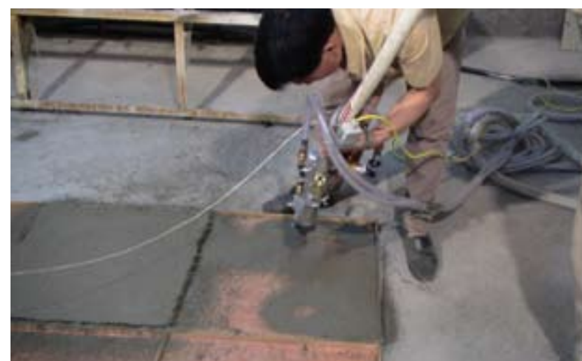
Fabrication de dalles en béton à fibres de verre
