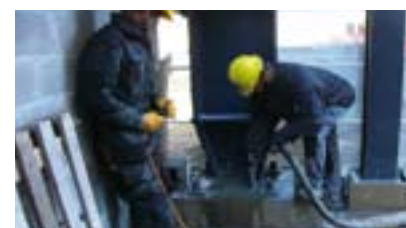
Remplissage de supports en acier dans un parking
