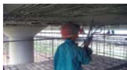
Rénovation de ponts
