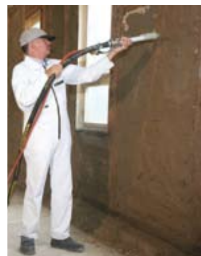
Projection d'enduit d'argile à l'intérieur
