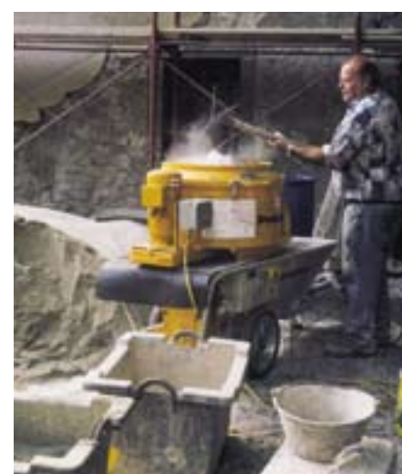
Chargement de la S 5 EV à la pelle
