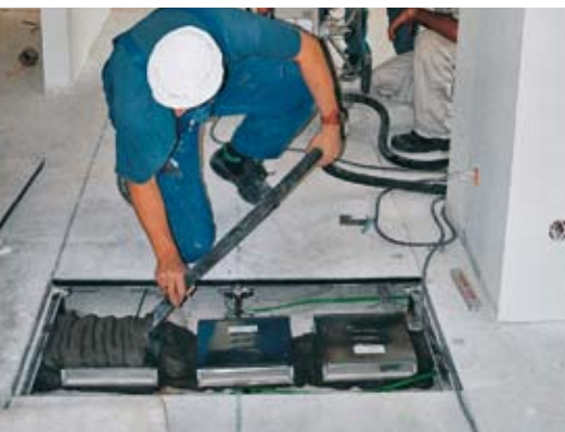
Remplissage de mortier de protection incendie autour de boîtier de distribution.
