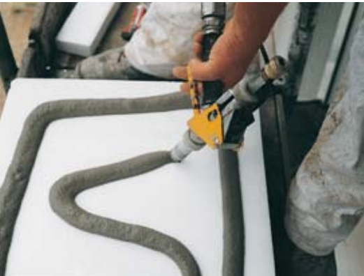
Encollage de plaque de polystyrène avec la lance adaptée dans le procédé ITE.
