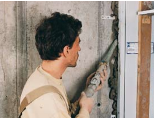
Le Sprayboy® en action avec une lance spéciale pour le remplissage derrière les cadres de portes.
